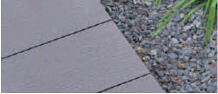
nach Reinigung mit Wasser
