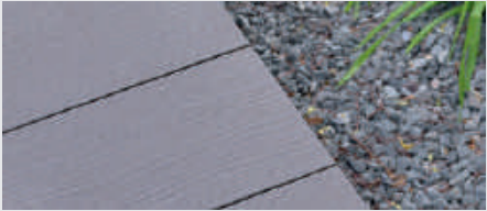
nach Reinigung mit Wasser
