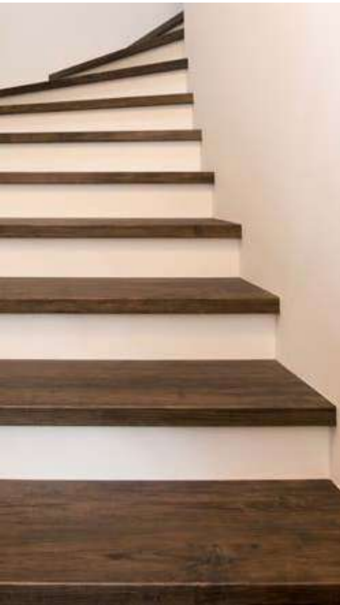
Trittstufe wird mit Bodendiele fortgeführt
