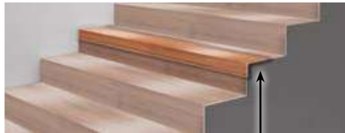
Trittstufe wird mit Bodendiele fortgeführt
