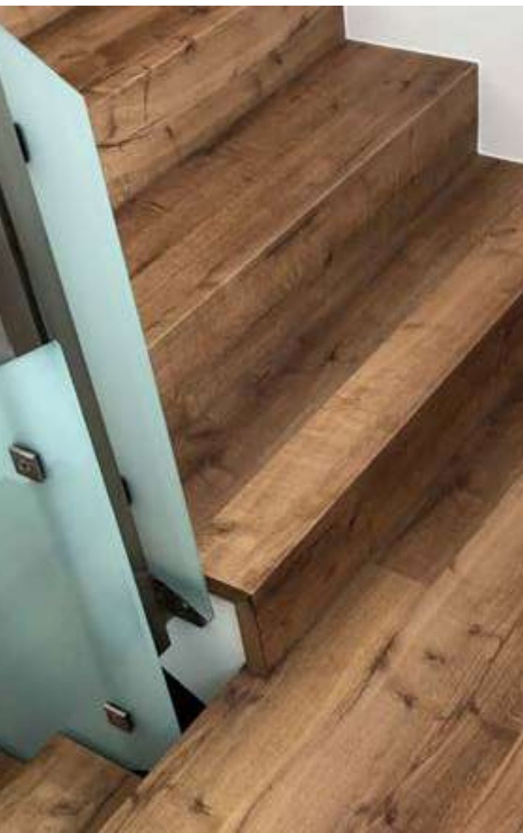
Trittstufe wird mit Bodendiele fortgeführt
